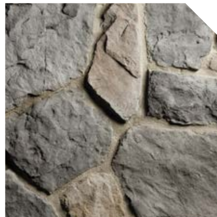
Avec joint de mortier plat
